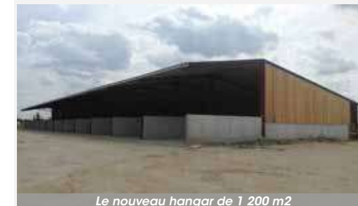
Le nouveau hangar de 1 200 m2
