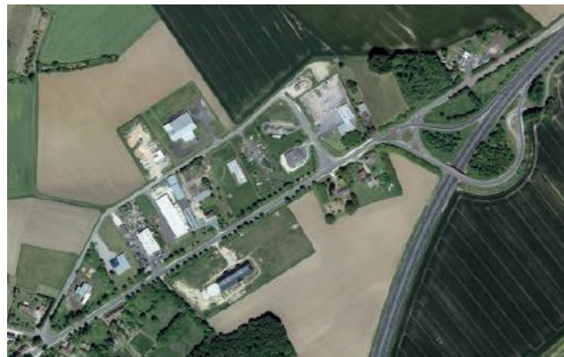
Zone d'activité « Les Noyers » à Vatan, vue du ciel
